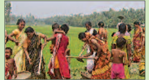
রাস্তা মেরামত কার্যক্রমে অংশগ্রহণকারীদের একাংশ
